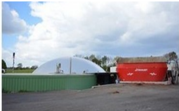
Porte-ouverte sur une unité de méthanisation agricole
